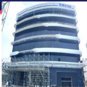
10/20~25 車間放樣動工
